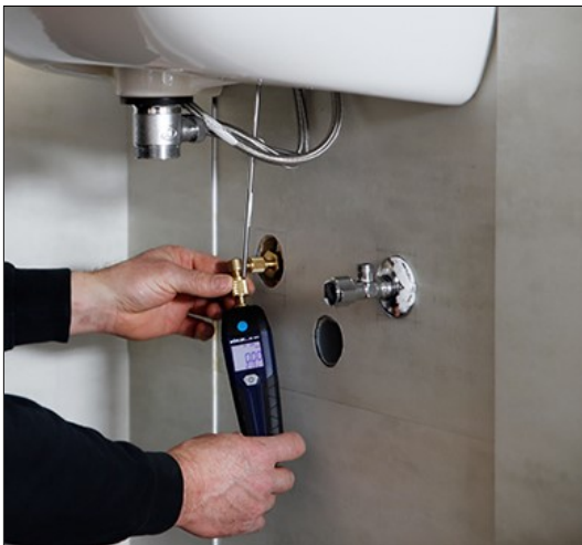
Abb. 7: Anschluss mit Winkeladapter 90° (Art. Nr. 8841)
